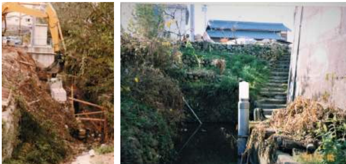
1984年7月豪雨で崩れた石垣復旧（1984年11月撮影）とその後の出水（1998年12月撮影）
